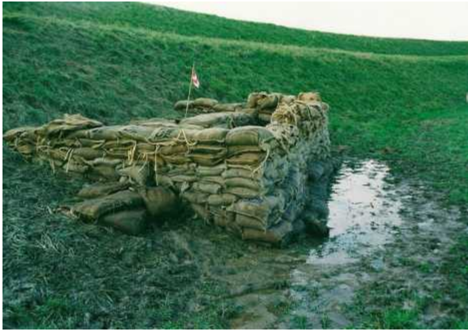
Realizzazione di una saccata in presenza di un fontanazzo
